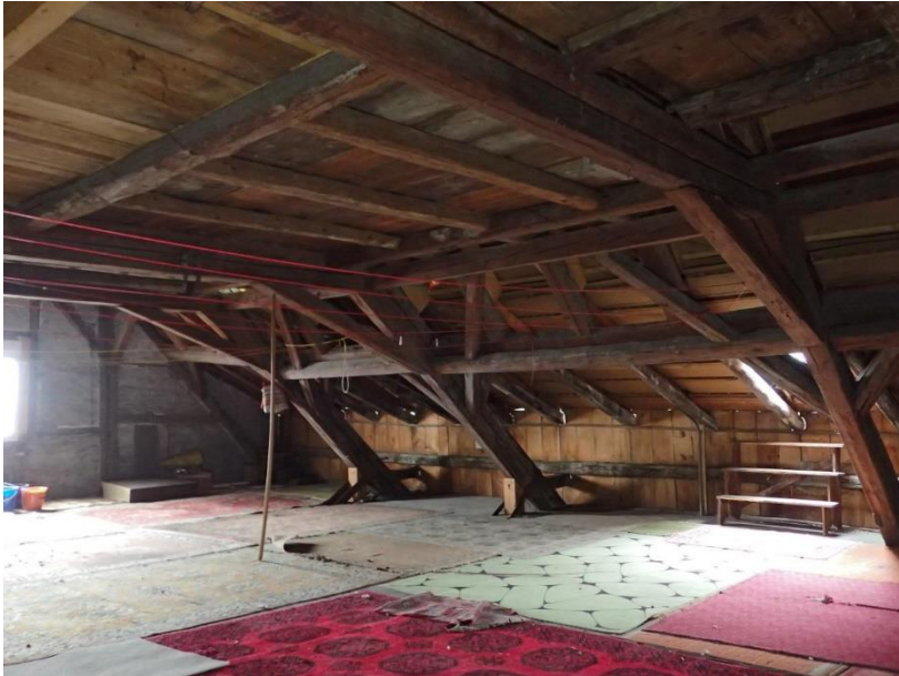
Blick in das Dachgeschoss. Daran ist zur erkennen, dass das Haus von Anfang an als Färberei konzipiert war.
